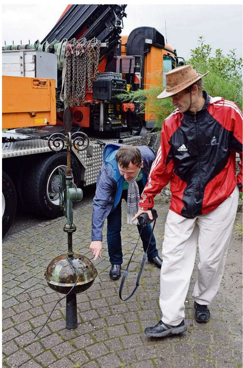
Stauen: Pfarrer Jörn Schlede (links) und Architekt Bruno Huber begutachten die Einschusslöcher in der Kugel.
