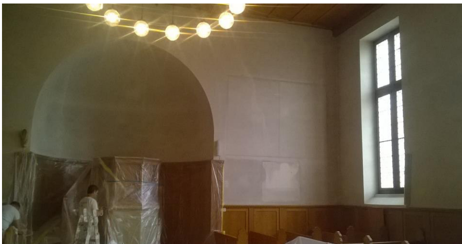
Während der Renovationsarbeiten wurden Mobiliar und die Orgel in der Zwinglikirche verpackt.
